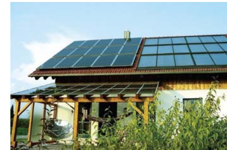
Wer über ein Süd-, Ost- oder Westdach verfügt, sollte dieses möglichst bald mit PV-Modulen bestücken
