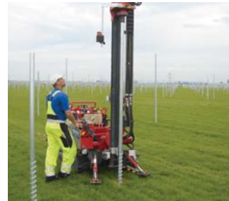
Die „Bodendübel“ werden zur Verankerung der Anlage in den Boden gedreht.
