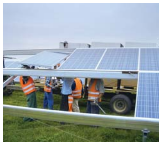
...und die Module montiert werden.
