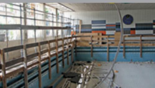
Das geflieste Becken aus den 1970er Jahren mit variabler Wassertiefe wurde im Rahmen der Sanierung der Mittelschule durch eine pflegeleichte Edelstahlwanne ersetzt.
