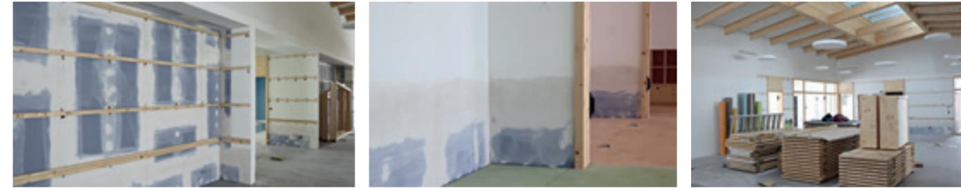
Nach der Trocknung des Bodenaufbaus wurde die Beplankung der Innenwände teils ganz oder bis auf eine Höhe von 50 cm erneuert.
