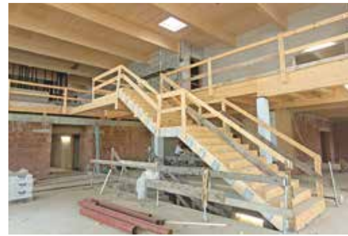
Eine freitragende Holzterrasse verbindet den Eingangsbereich im Erdgeschoss mit dem erweiterten Foyer im Obergeschoss
