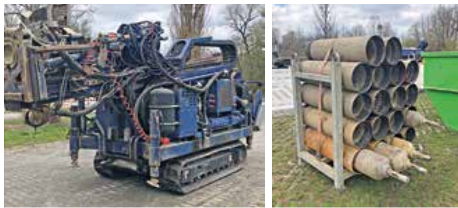
Mit einem Bohrgerät wurde mittels des Bohrgestänges (rechts) ein 15 Meter tiefes Bohrloch zur Grundwasserbeobachtung erstellt.
