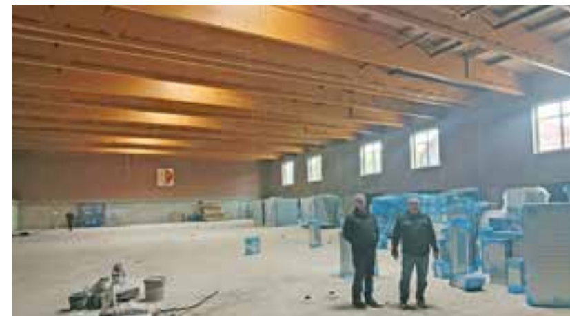
Stadtbaumeister Gerhard Binner und Projektleiter Jürgen Sarcher in der entkernten Dreifachturnhalle. Lediglich das Tragwerk der Dachkonstruktion und der Aufbau der Tribünen blieben unverändert. Der Zugang zu den Tribünen erfolgt nach dem Umbau nicht mehr seitlich, sondern von hinten.
