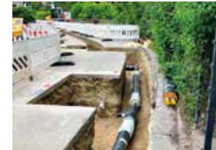
Der Ausbau des Wärmenetzes, wie bereits 2023 im Saliterweg und der Brückenstraße erfolgt, steht in den kommenden Jahren im Fokus der Stadtwerke Vilsbiburg.
