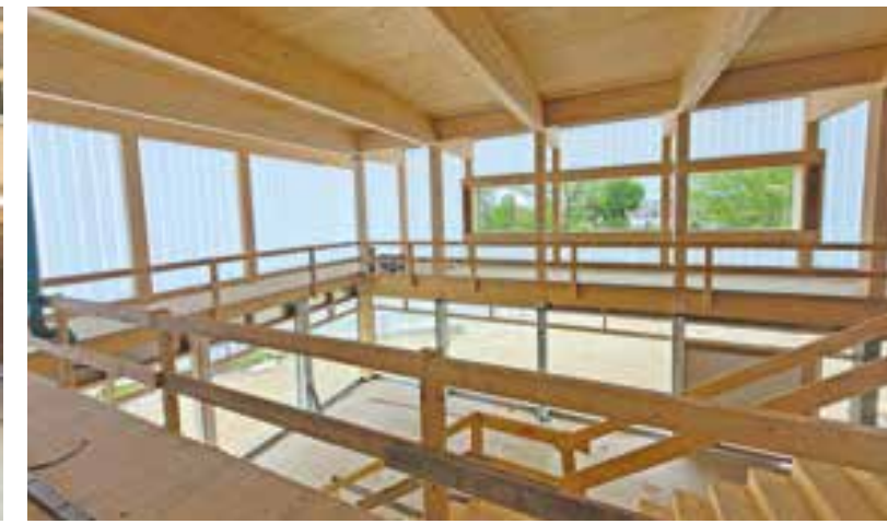
Eine freitragende Holzterrasse verbindet den Eingangsbereich im Erdgeschoss mit dem erweiterten Foyer im Obergeschoss
