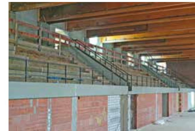
Stadtbaumeister Gerhard Binner und Projektleiter Jürgen Sarcher in der entkernten Dreifachturnhalle. Lediglich das Tragwerk der Dachkonstruktion und der Aufbau der Tribünen blieben unverändert. Der Zugang zu den Tribünen erfolgt nach dem Umbau nicht mehr seitlich, sondern von hinten.
