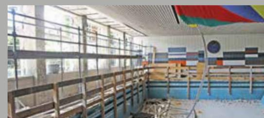
Das Hallenbad wird mit einer Stahlwanne ausgekleidet.
