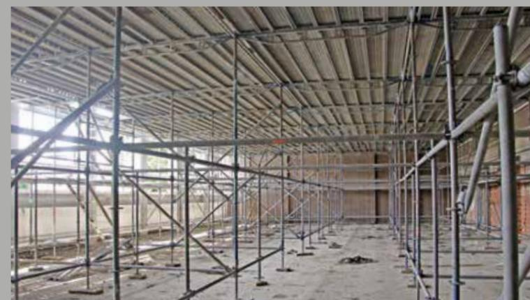
Zur Sanierung der Decke in der Turnhalle wurde ein Raumgerüst aufgestellt.
