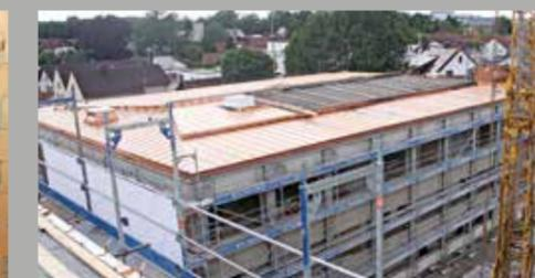
Links: Die erste Kernbohrung im bestehenden Eingangsbereich für den Zugang zum Sporttrakt. / Mitte: Noch im Rohbau - die Umkleiden für das Hallenbad / Rechts: Sowohl der Schultrakt, als auch der Sporttrakt erhalten ein neues Kupferdach.
